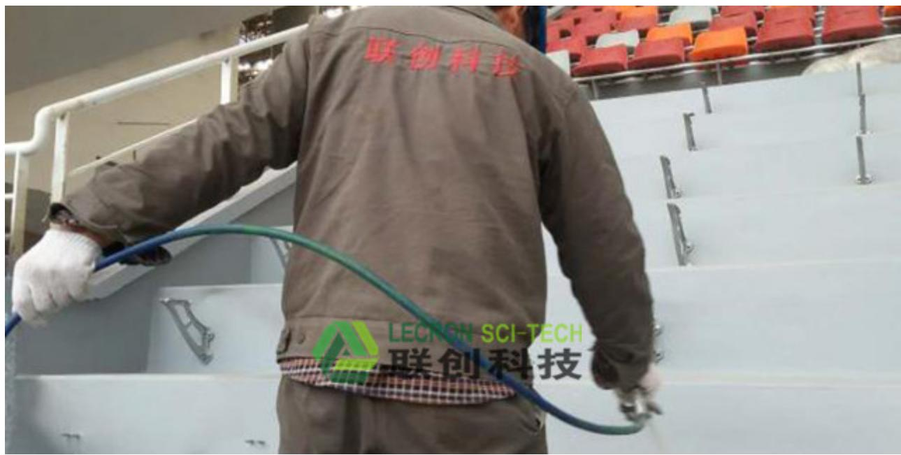
聚脲防腐施工应用很普遍，不同行业、不同产品上也时不时会被见到披着聚脲防腐的外衣，施工的对象不同，施工工艺还是有些差别的虽然大体的施工差不多，但是在很多细节的处理上是不一样的，因为施工对象是不一样的，下面是联创科技在平面上施工时的流程：1、清理找平层聚脲防腐施工施工前，应用清扫工具将找平层清扫干净，清理水泥面上的水泥灰、油脂及其他异物。混凝土表面上的水泥浮沫、脱模剂及固化剂须用钢刷、凿石锤、喷砂等方法去除。用砂轮
